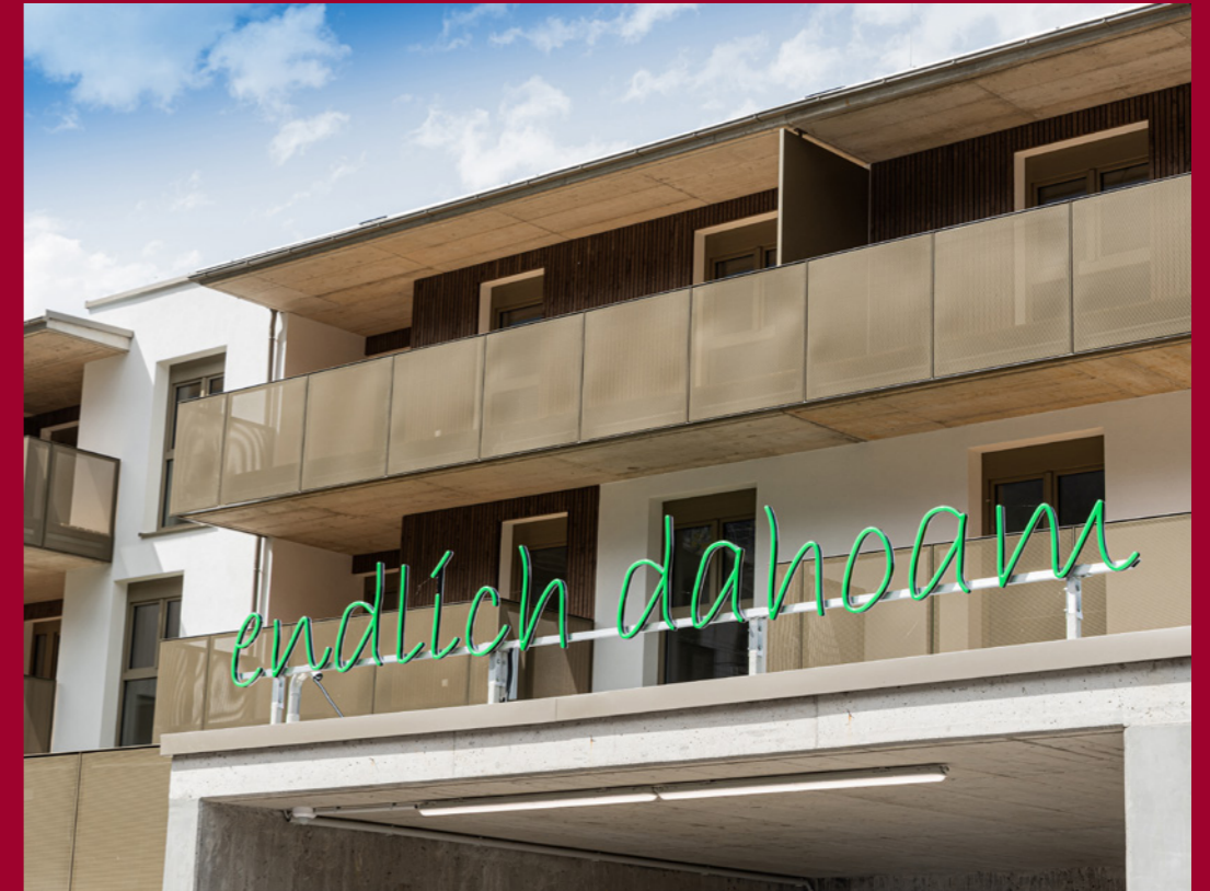
Wohnanlage Polling, Sennerareal
